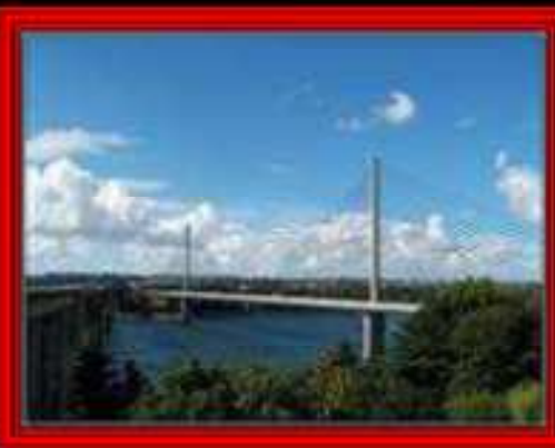
Système d'acquisition 32 voies pour mesures sur tabliers de pont
