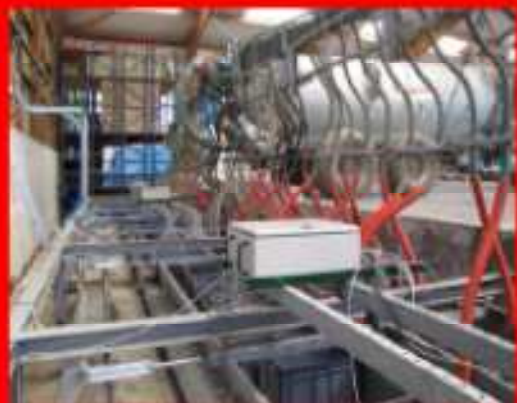
Système de pesée de 72 balances pour répartition d'épandage
