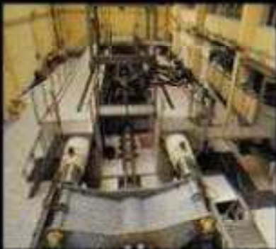
Rénovation du système de contrôle d'un banc de traction de câbles suspension de ponts.
