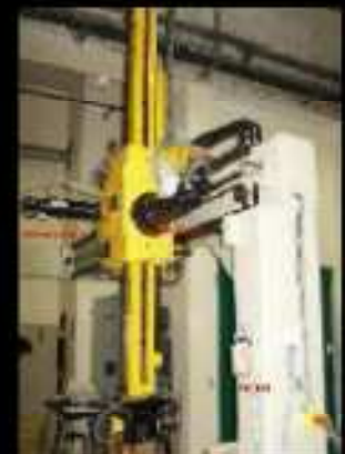
Rénovation du contrôle commande d'un robot manipulateur 2 axes.
